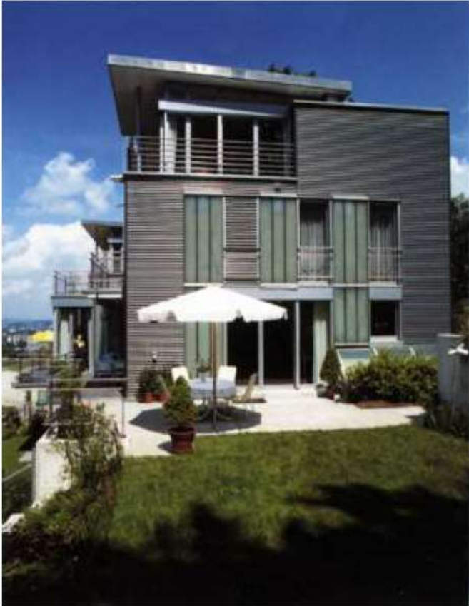
Doppelfamilienhaus Stadlin/Bertschi in Zug (CH)
