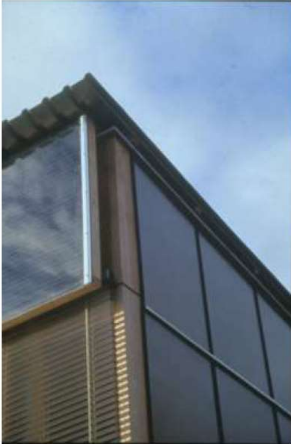
Doppelwohnhaus in Bregenz II
