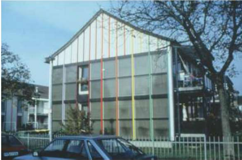
Mehrfamilienhaus Sonnenackerweg, Freiburg II
